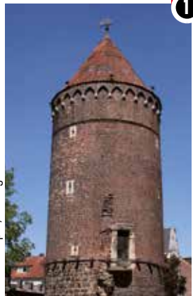
Siebenteufelsturm Haltern am See
